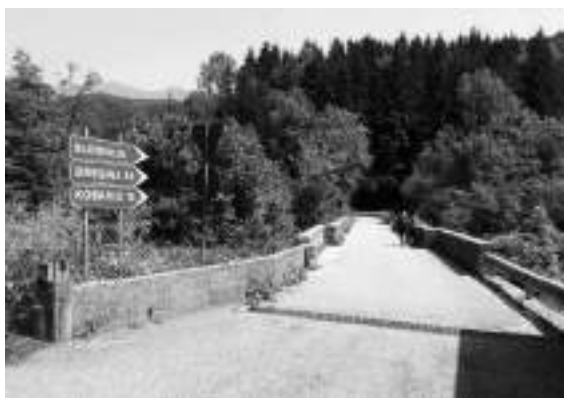
Opuščeni maloobmejni prehod na mostu Ponte Vittorio na Nadiži, onkraj Breginja.
