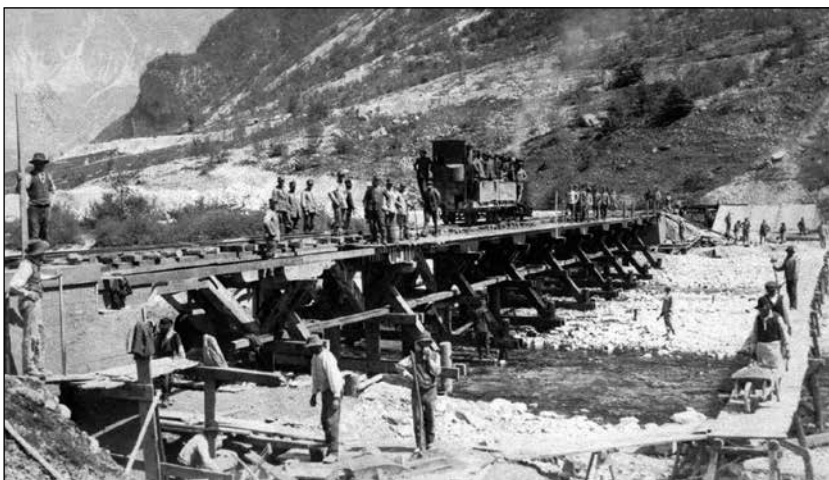
Gradnja mostu čez Nadižo pri Poljani
