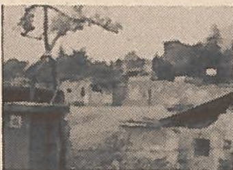
Pretrsljiv pogled se še danes ponuja obiskovalcu Humina (Gemona di Friuli), saj je še po letu dni, odkar je bil potres, vse v ruševinah. Le redka poslopja so obnovljena v središču mesta.
