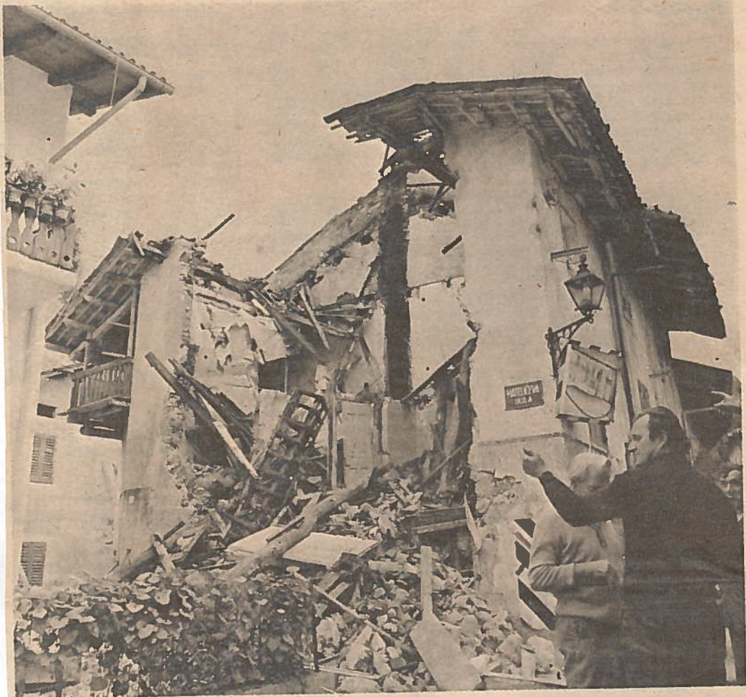
Včerajšnji potres je prizadel številne kraje v Posočju. Na posnetku je močno poškodovana stanovanjska hiša v Kobaridu. Foto: D. CVETNIČ
