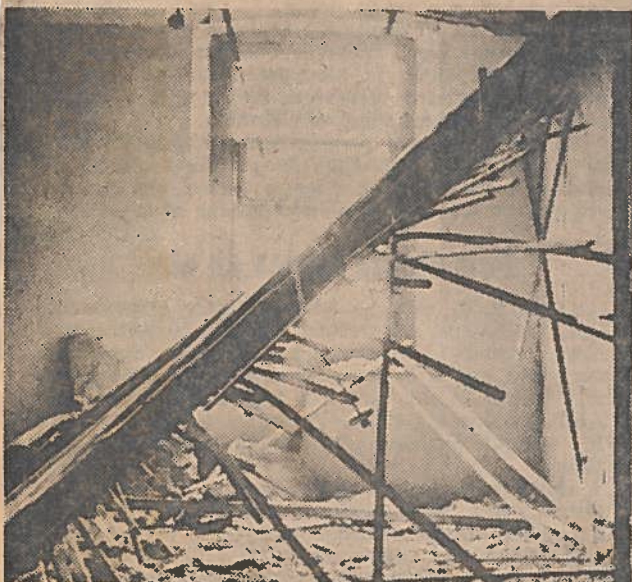
POŠKODBE V BOHINJU — Takšna je po jutranjem potresu ostala notranjost zadruga v Srednji vasi. Foto: Sveto Busič
